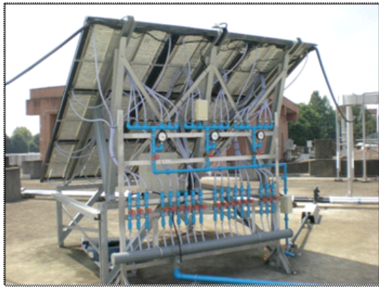
図8 冷却装置取り付け状況全景
