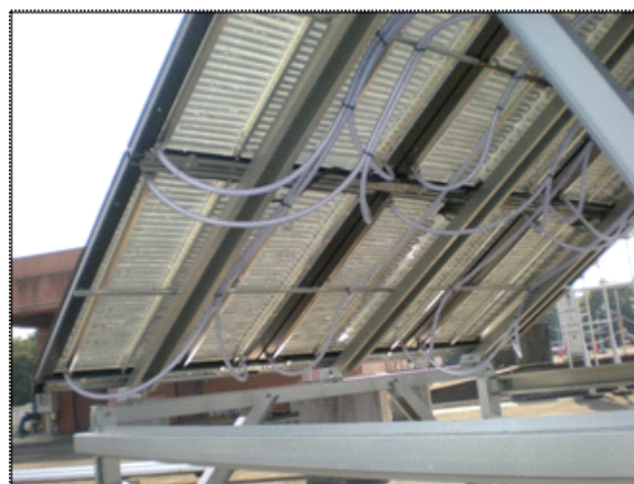
図7 冷却装置取り付け状況
