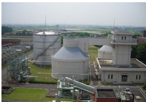
写真-1 嫌気性汚泥消化施設
