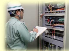
下水道部 下水道資源化工場 主任 田崎 佑哉 (電気職/入社5年目)
