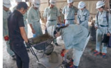
コンクリート基礎研修
