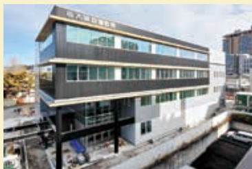
【工事監理】栃木県自治会館新築工事 (栃木県市町村総合事務組合)
