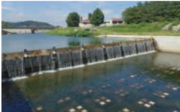
【積算】二杉堰建設工事 一級河川永野川 (栃木土木)
