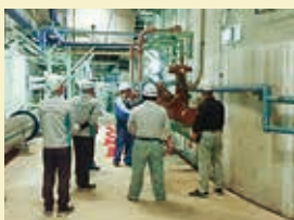
芳賀町水処理センター支援（改築更新計画協議）
