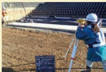
【積算・現場技術】駅東児童公園雨水対策工事 (高根沢町)
