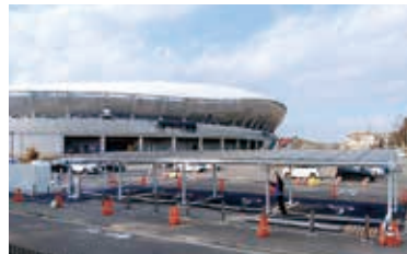
【工事監理】県総合運動公園防災拠点施設 再エネ等工事
