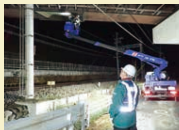
東武鉄道跨線橋の夜間点検(日光市)
