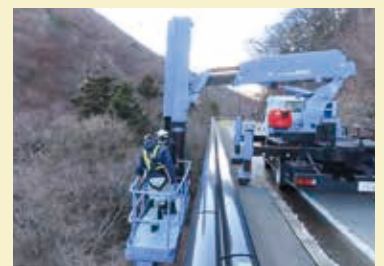
橋梁点検車による橋梁点検(那須塩原市)
