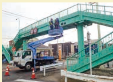
高所作業車による歩道橋点検(壬生町)
