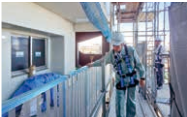
【工事監理】県営若草住宅1号棟新築工事
