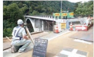
【現場技術】道路改良工事 国道400号下塩原BP (大田原土木)
