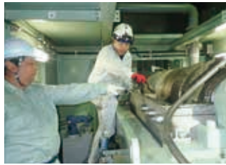
汚泥脱水機点検立会
