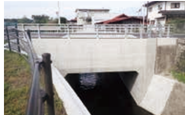
【積算】旭橋函渠建設工事 県道東小屋黒羽線 (大田原土木)
