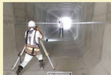
【積算・現場技術】雨水渠幹線整備工事 (永野川左岸第1排水区) (栃木市)
