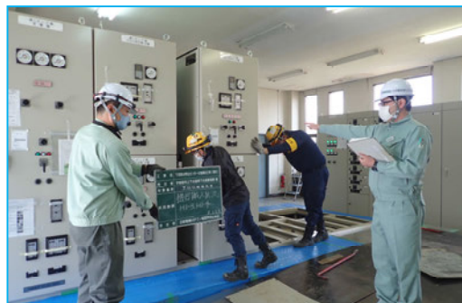
施工管理支援(下河原水再生センター)
