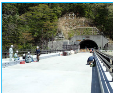
施工管理(大田原土木)
