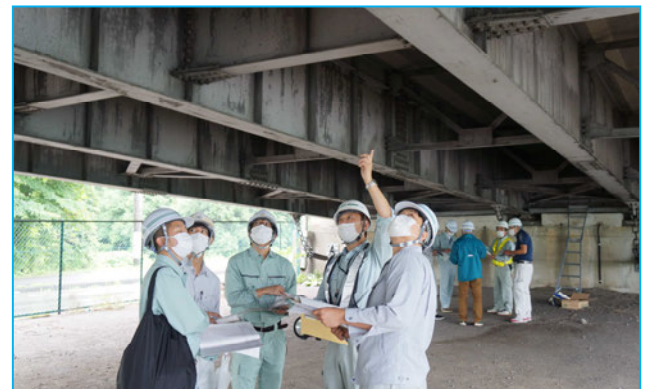
道路橋点検診断と補修研修
