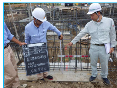
工事監理(GSZ整備室)
