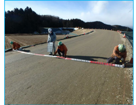
積算・施工管理(矢板市)
