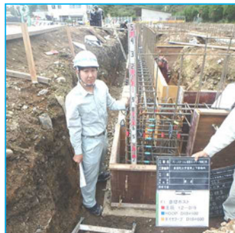
工事監理(那須町)
