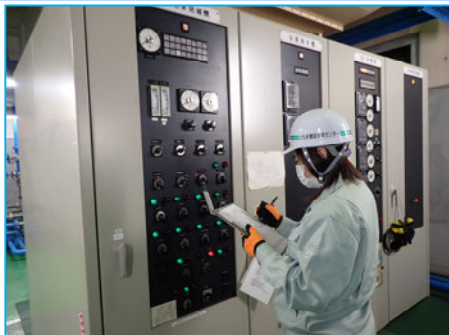
機能評価(県央浄化センター)
