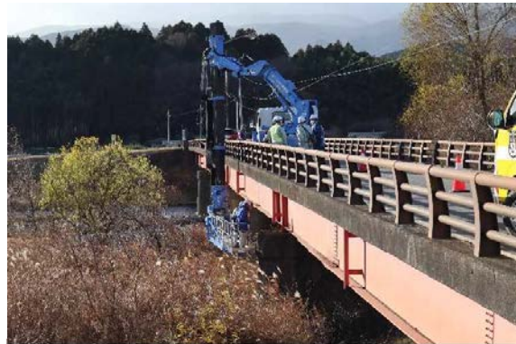
道路施設点検診断監理業務の点検状況
