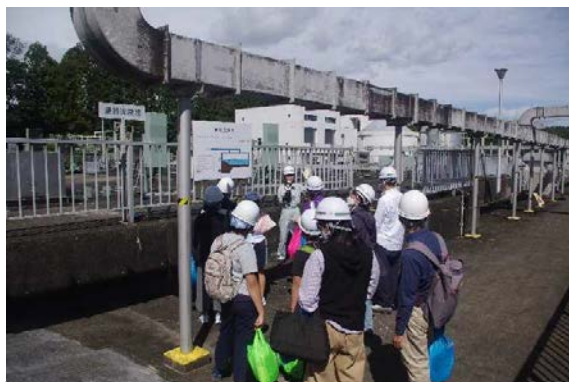
北那須浄化センターの下水道施設公開状況
