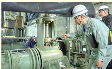
修繕工事の監督
