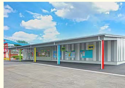
【工事監理】とちのきファミリーランド事務所整備工事 (栃木県民公園福祉協会)
