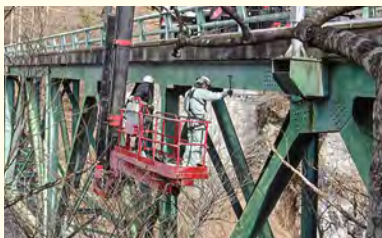
橋梁点検車による開運橋の点検(日光市)
