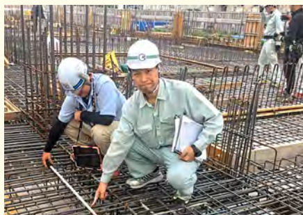
【工事監理】県営若草住宅新1号棟新築工事 (県建築課)
