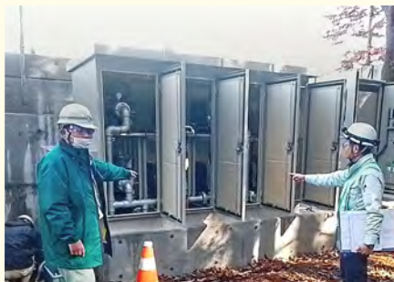
【工事監理】浄化槽・受水槽整備更新工事(日光口PA) (栃木県道路公社)
