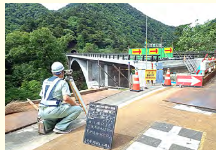
【工事管理】道路改良工事 400号下塩原BP (大田原土木)
