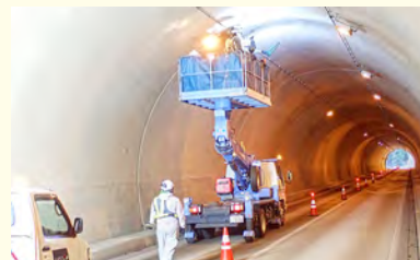
リフト車による木佐美南方トンネル内点検(大田原市)
