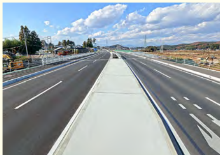
【積算】道路改良工事 宇都宮鹿沼線 (鹿沼土木)
