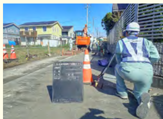
【工事管理(下水道)】
