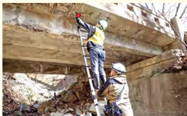
はしごによる峠沢橋点検(日光市)
