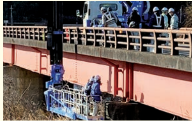
橋梁点検車による宇都野橋点検(那須塩原市)
