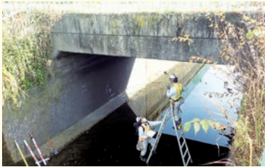
はしごによるボックスカルバート点検(塩谷町)
