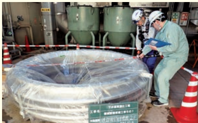
修繕工事の監督
