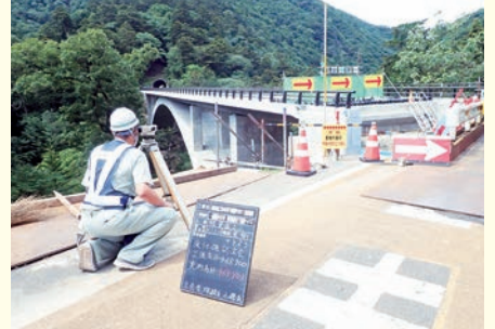
【工事管理】道路改良工事 400号下塩原BP (栃木県大田原土木)
