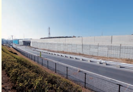
【積算】擁壁工事 408号宇都宮高根沢BP (栃木県宇都宮土木)
