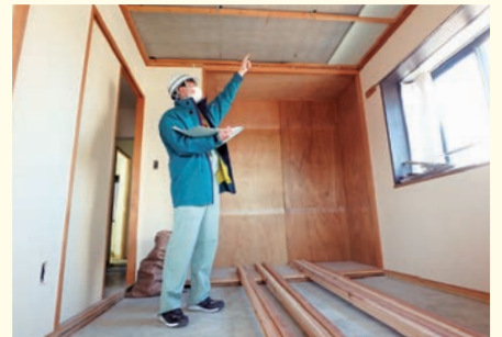
【工事監理】マロニエハイツ今泉リノベーション工事 (栃木県住宅供給公社)
