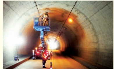
リフト車による小白井トンネル内点検(那須烏山市)
