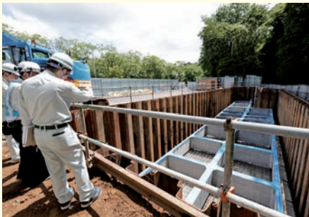
【工事監理】浄化槽・受水槽整備更新工事 (日光OPA) (栃木県道路公社)
