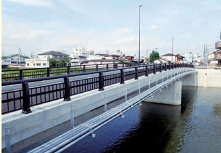
【積算】一級河川秋山川 中橋上部工設置工事 (栃木県安足土木)
